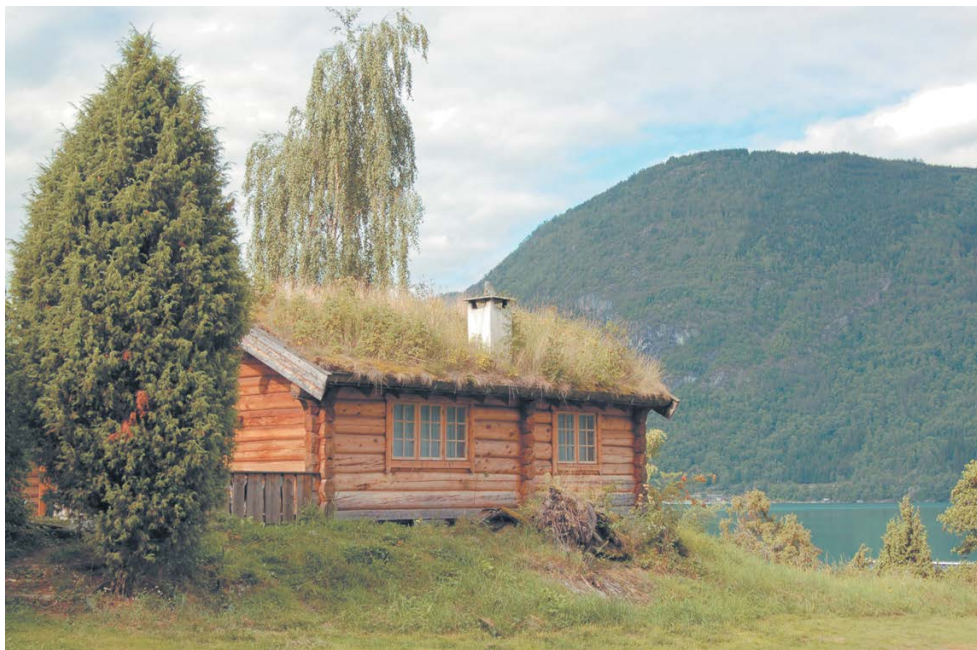
Рис. 18. Строение с дерновой крышей
