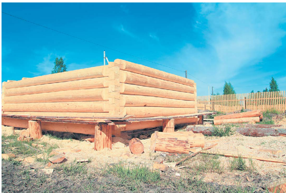
Рис. 25. Возведение стен «в лапу»
