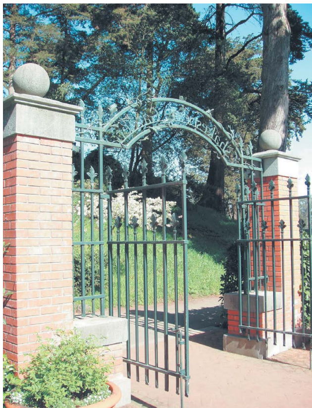
Рис. 13. Стойка ворот не должна иметь прямую жесткую связь с кирпичной кладкой
