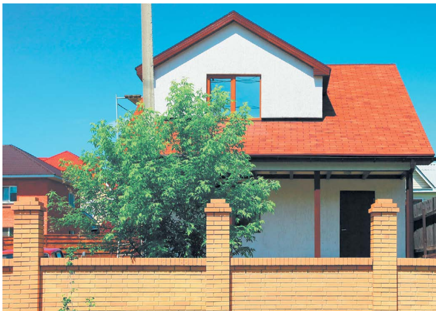
Рис. 8. Секционная кирпичная ограда
