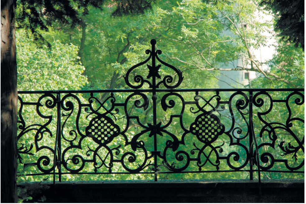
Рис. 3. Сварное чугунное ограждение
