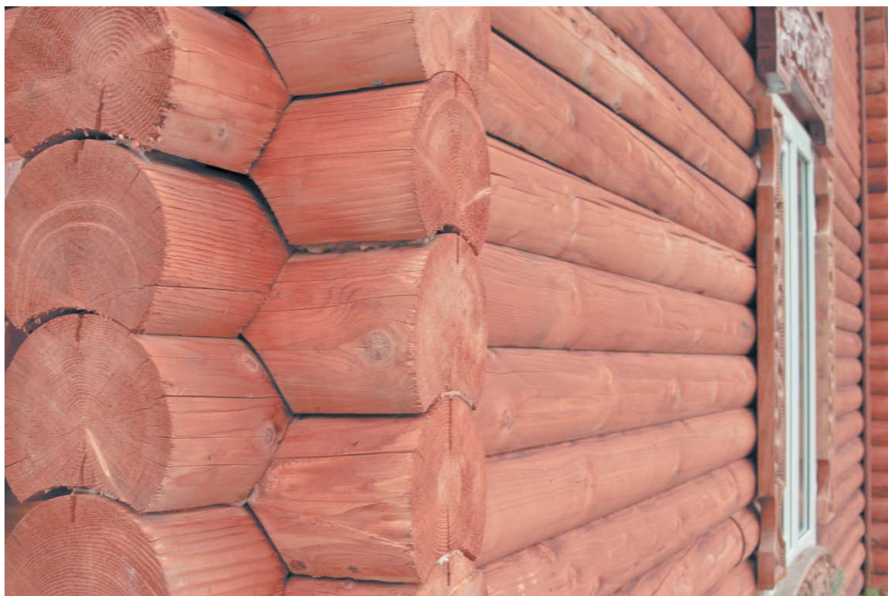
Рис. 24. Угол сруба, возведенного «в чашу»
