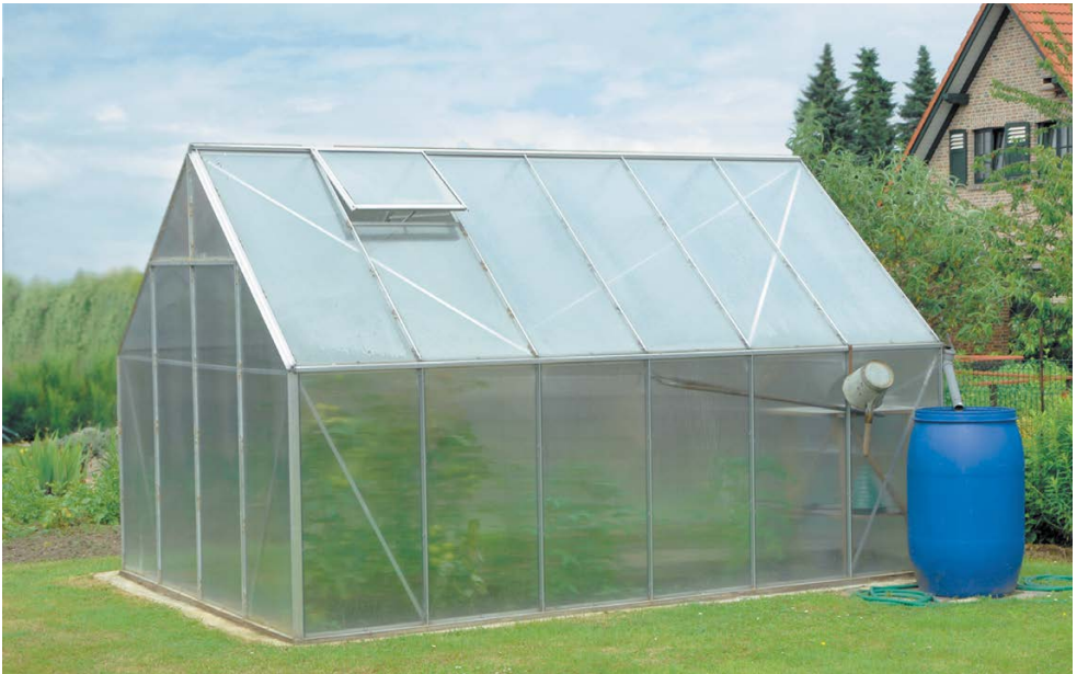
Рис. 31. Каркасная теплица с полиэтиленовыми стенами
