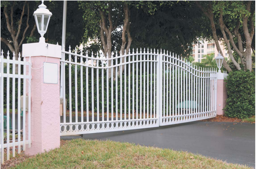
Рис. 12. Ворота с бетонными стойками
