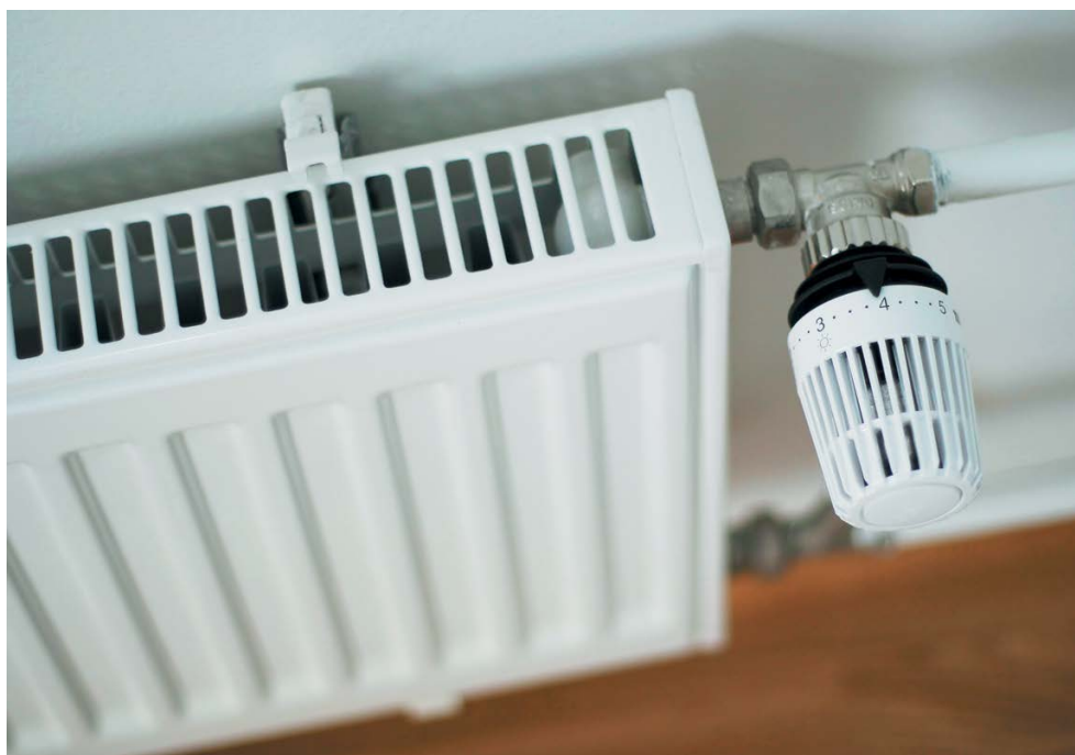
Рис. 39. Стальной панельный радиатор
