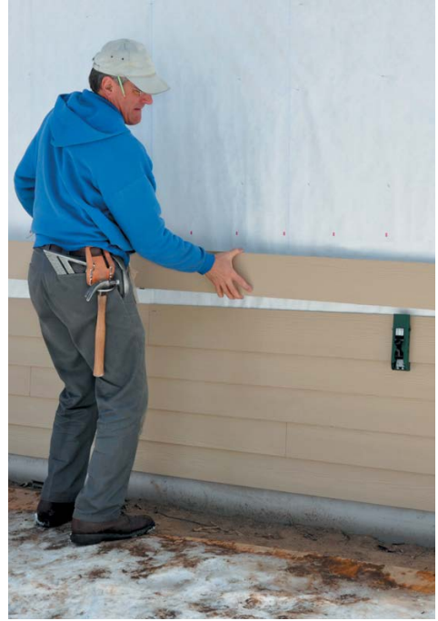
Рис. 43. Установка очередных ламелей
