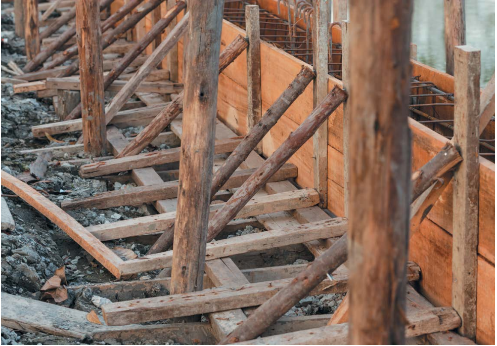
Рис. 5. Опалубка ленточного фундамента
