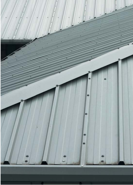
Рис. 16. Стальной лист, оцинкованный или окрашенный, постепенно уходит в прошлое
