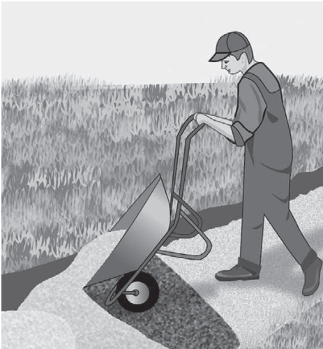
Рис. 3.7. Доставка песка для устройства песчаной подушки
