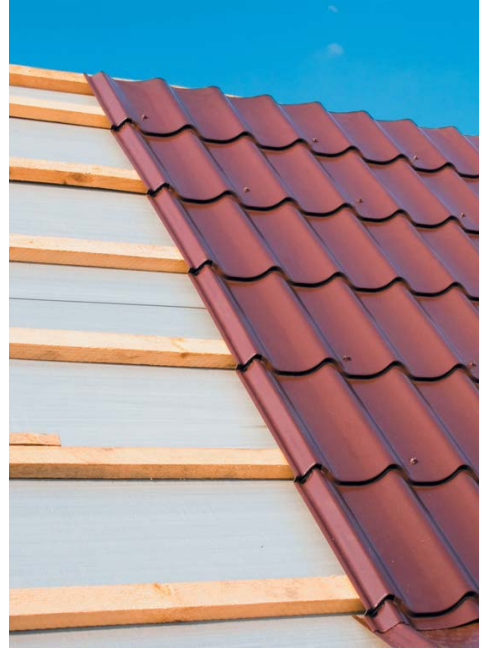
Рис. 17. Кровля из металлочерепицы
