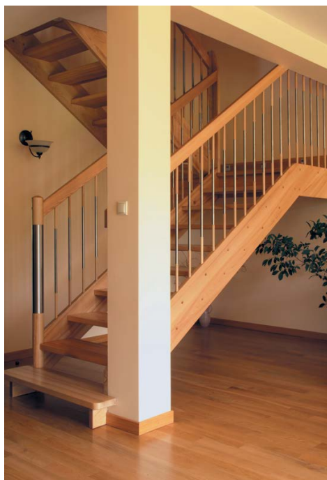
Рис. 30. Простое решетчатое ограждение
