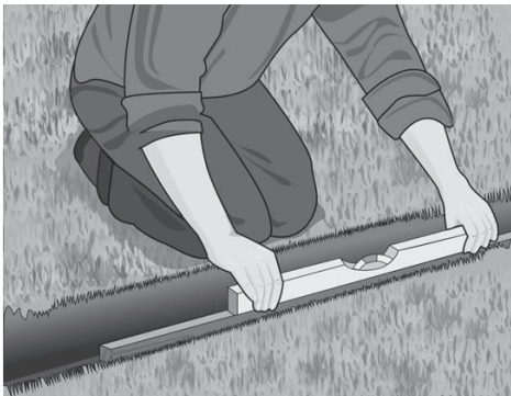
Рис. 2.5. Проверка траншеи под дренаж уровнем
