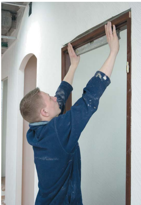
Рис. 24. Проверка вертикальности дверной коробки
