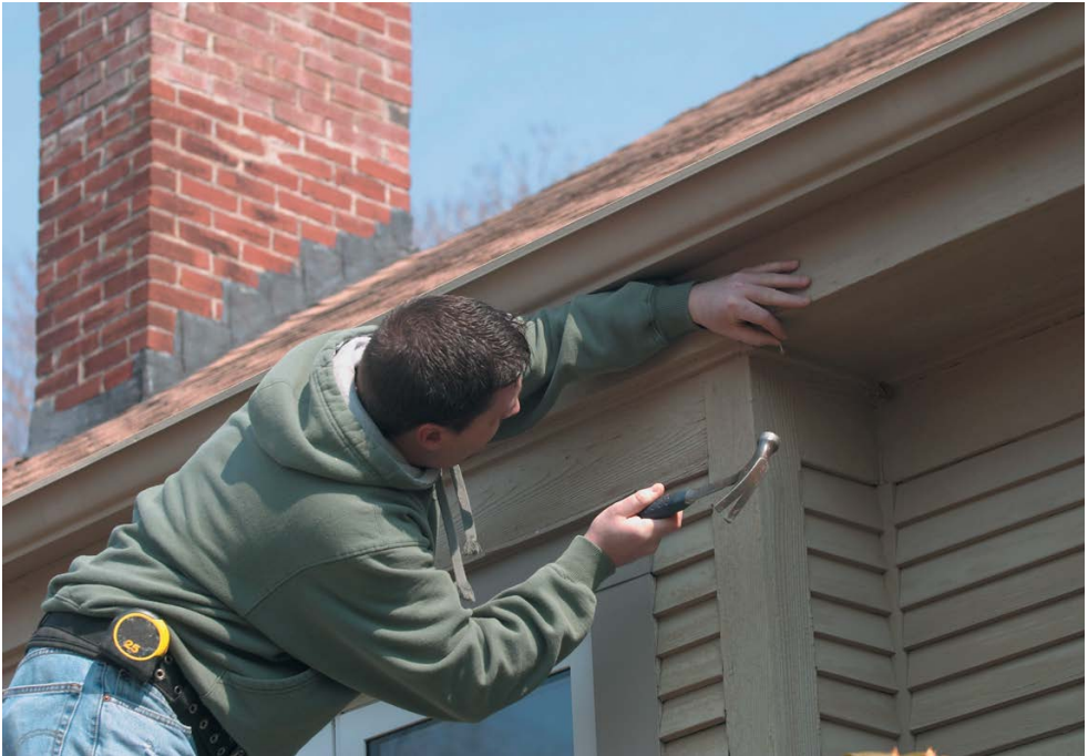
Рис. 44. Завершение монтажа сайдинга
