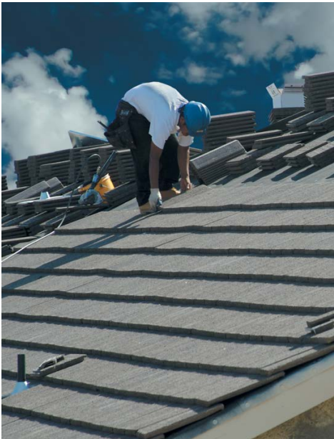
Рис. 18. Укладка кровли из керамической черепицы
