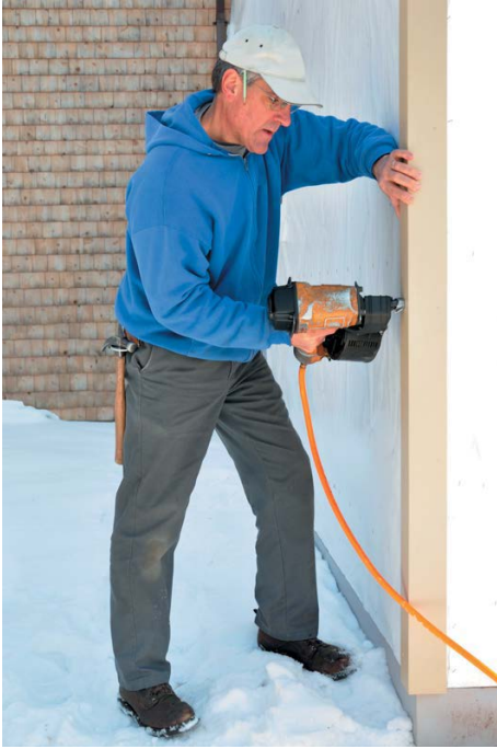
Рис. 42. Крепление углового элемента
