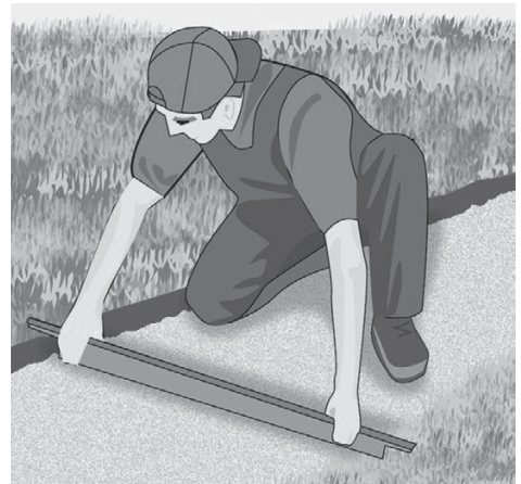
Рис. 3.9. Выравнивание песка рейкой
